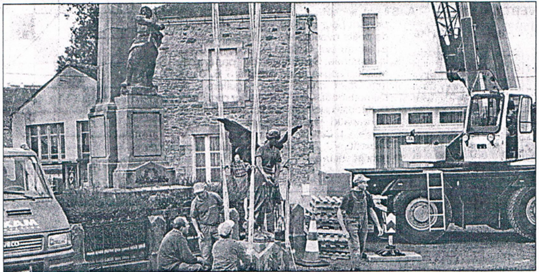
Les statues du monument aux morts ont été démontées, mercredi 27. Aussi périlleux soit-il, le chantier s'est très bien déroulé.
